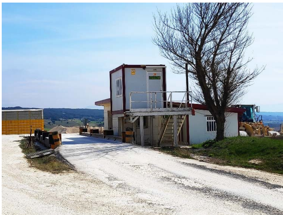
Detalle de la bascula de pesaje de residuos y caseta de control de entrada
