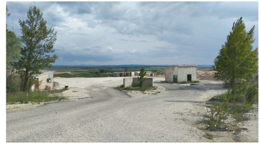
ZONA DE TRATAMIENTO
